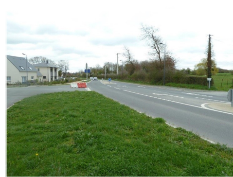
frange nord-ouest le long de la D105, rue des Landes
